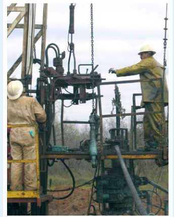
Här pågår renovering av en gammal brunn i östra Texas. Man ersätter alla gamla sönderrostade rör med nya friska rör.
